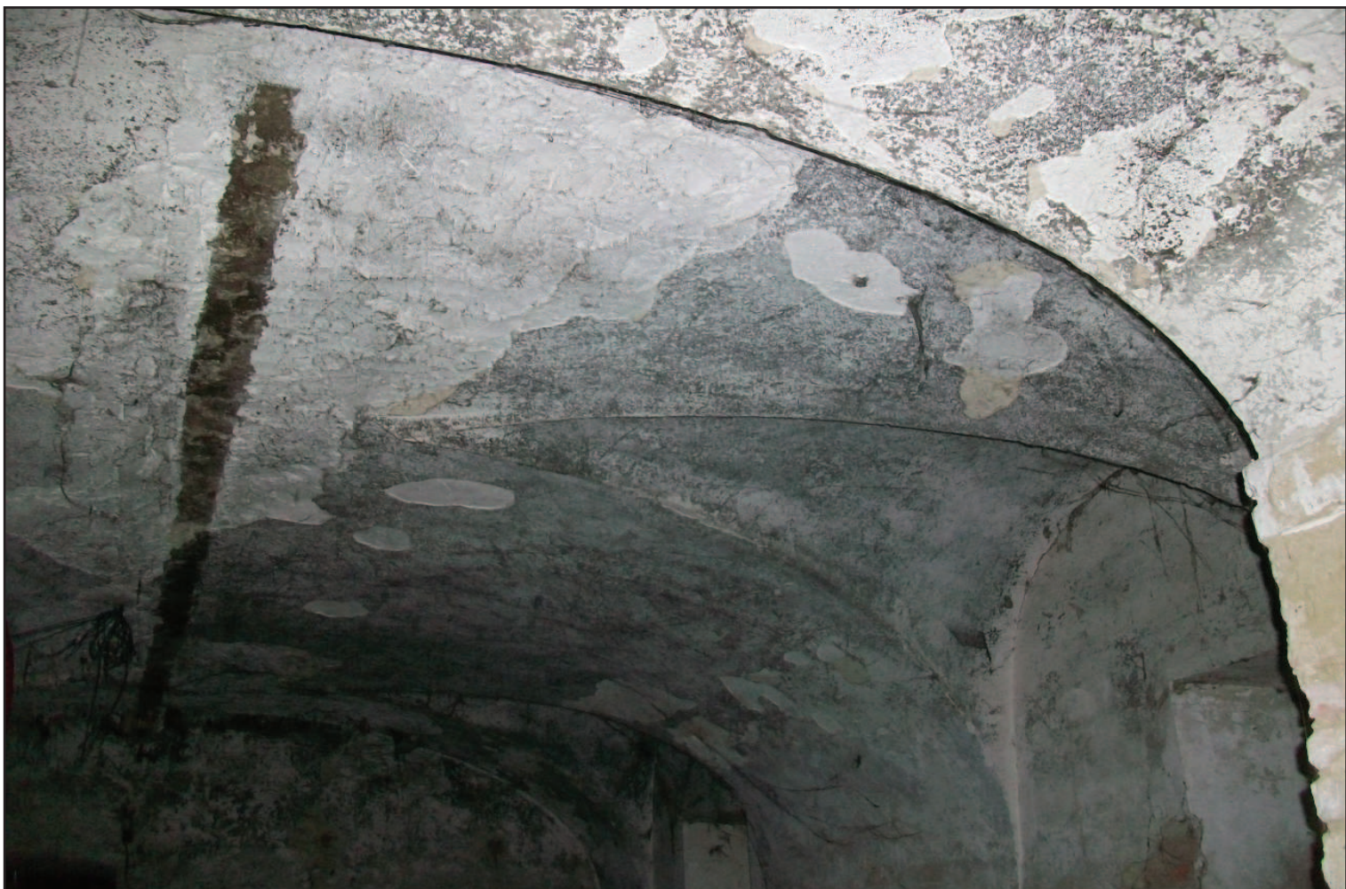
Particolare della volta a crociera
