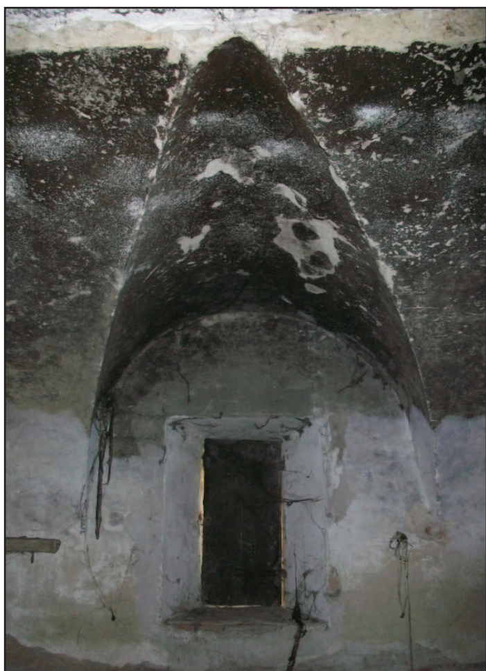
VISTA N. 8 : Particolare finestra
