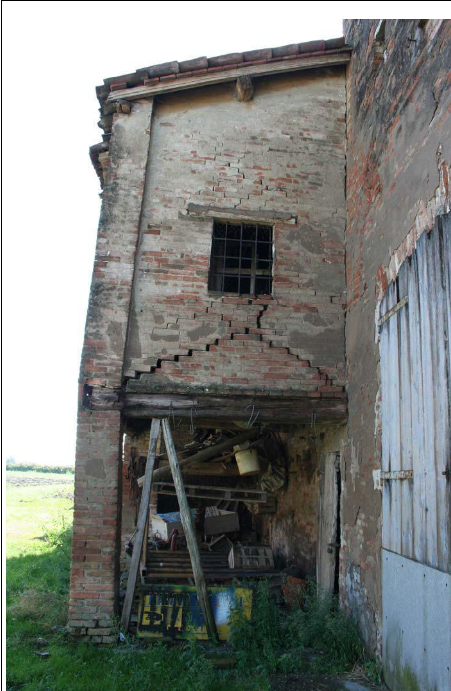
Foto n.2 – fronte nord ovest
