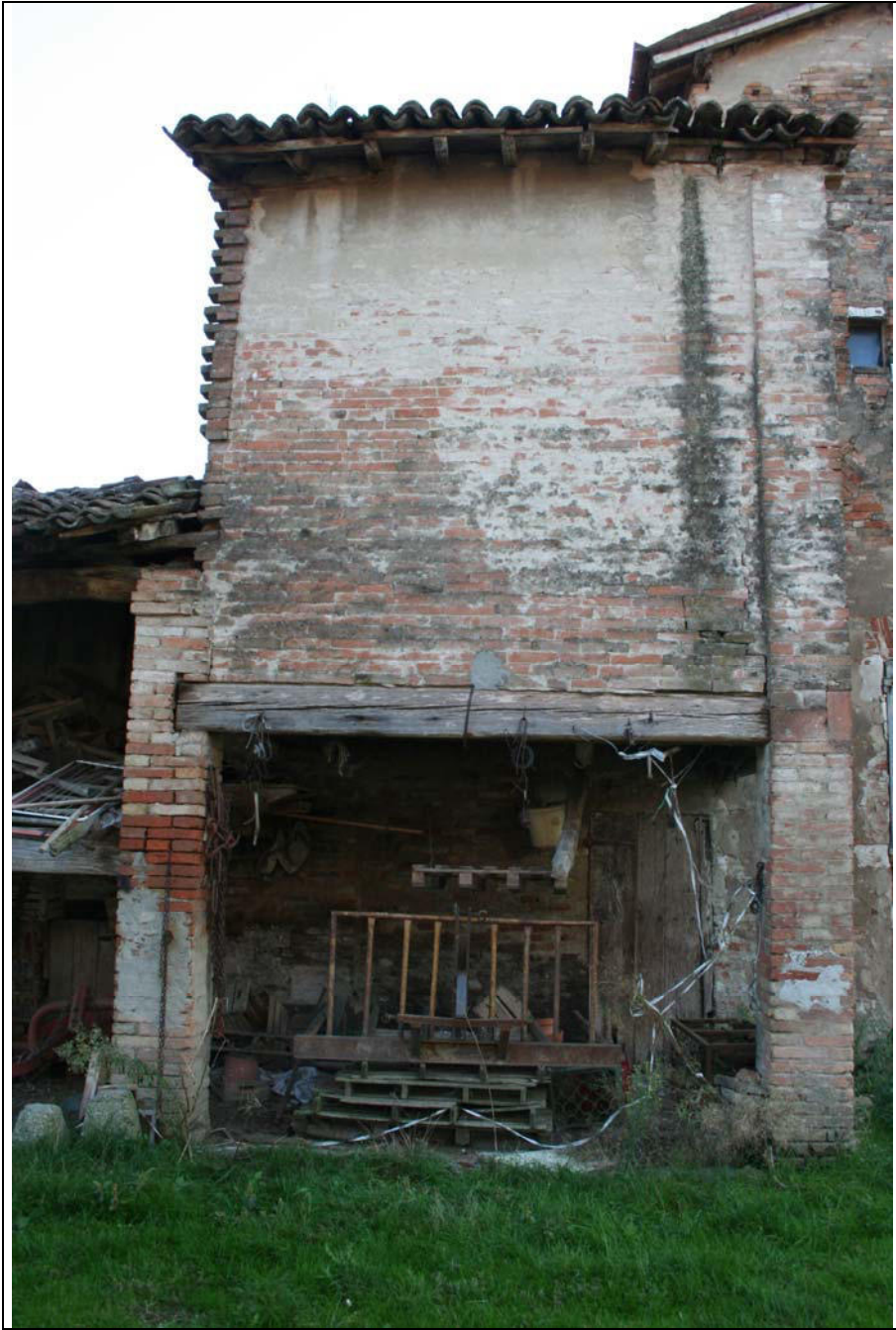
Foto n.3 – fronte nord est
