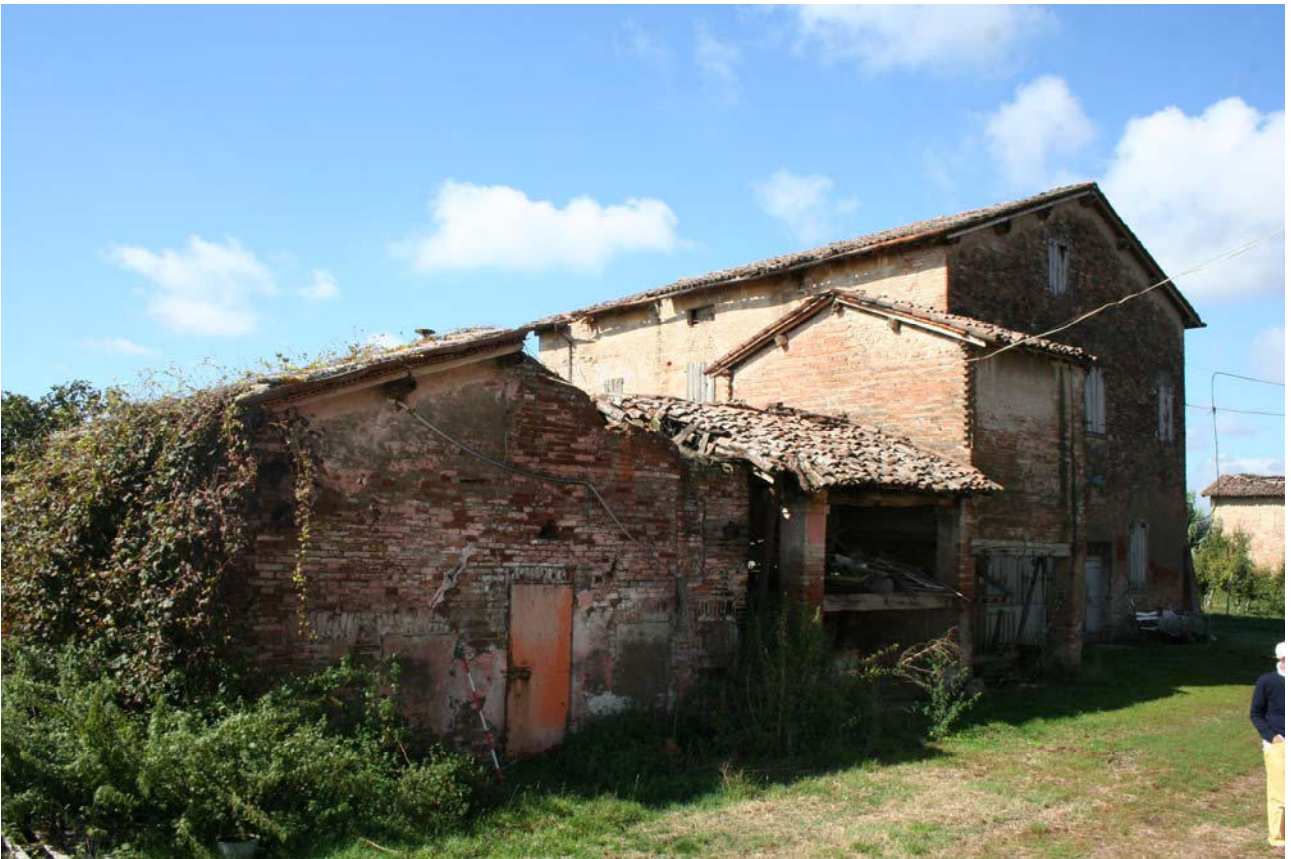
Foto 5 – corpi A,B,C - fronte sud ovest
