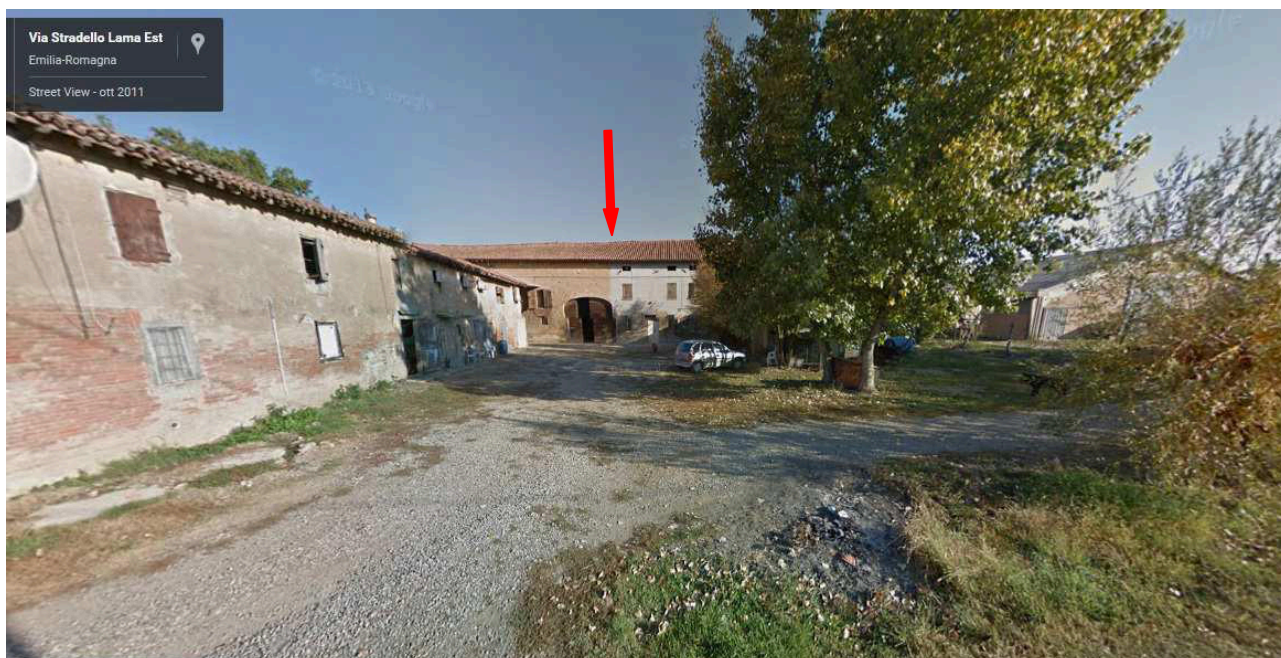
Vista della corte colonica da sud (Fonte Google maps)
