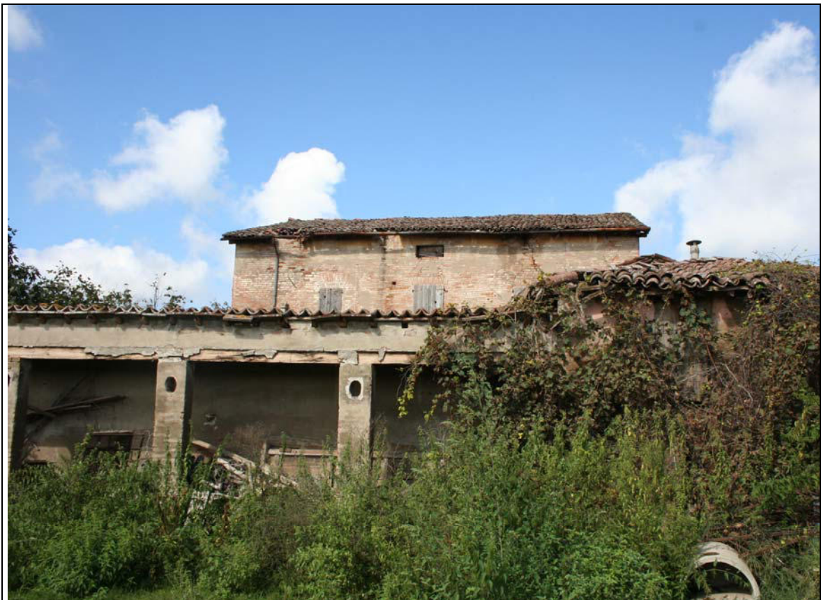
Foto n.5 fronte sud est
