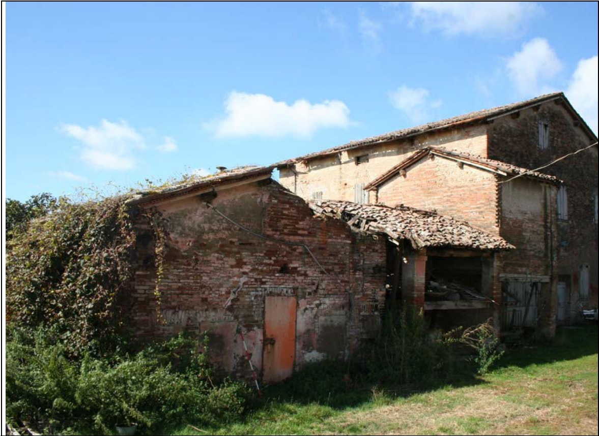
Foto n.4 - fronte nord est
