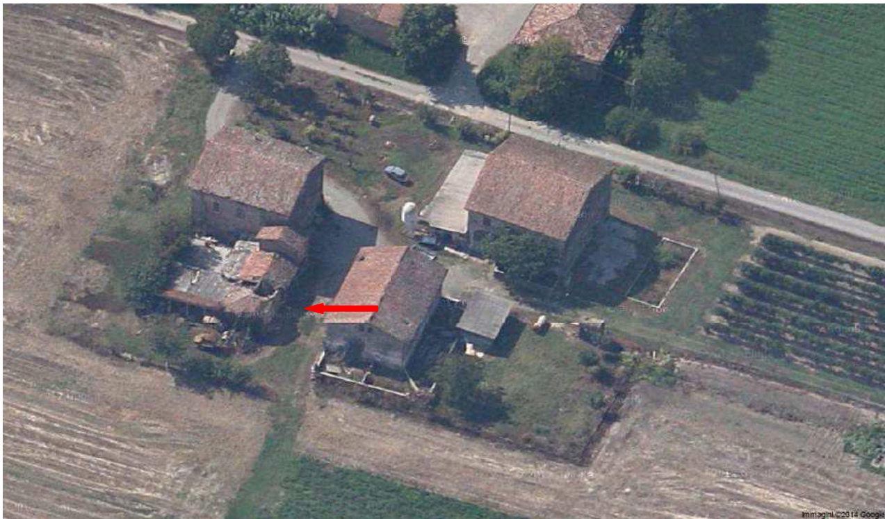
Vista della corte da est (Fonte Google maps)
