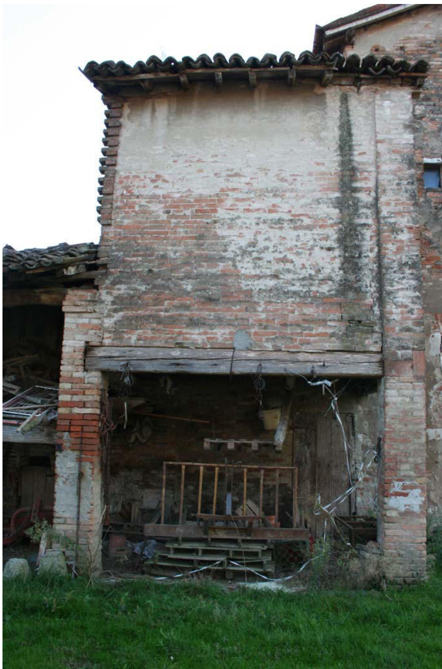
Foto 2 – porzione A fronte sud ovest
