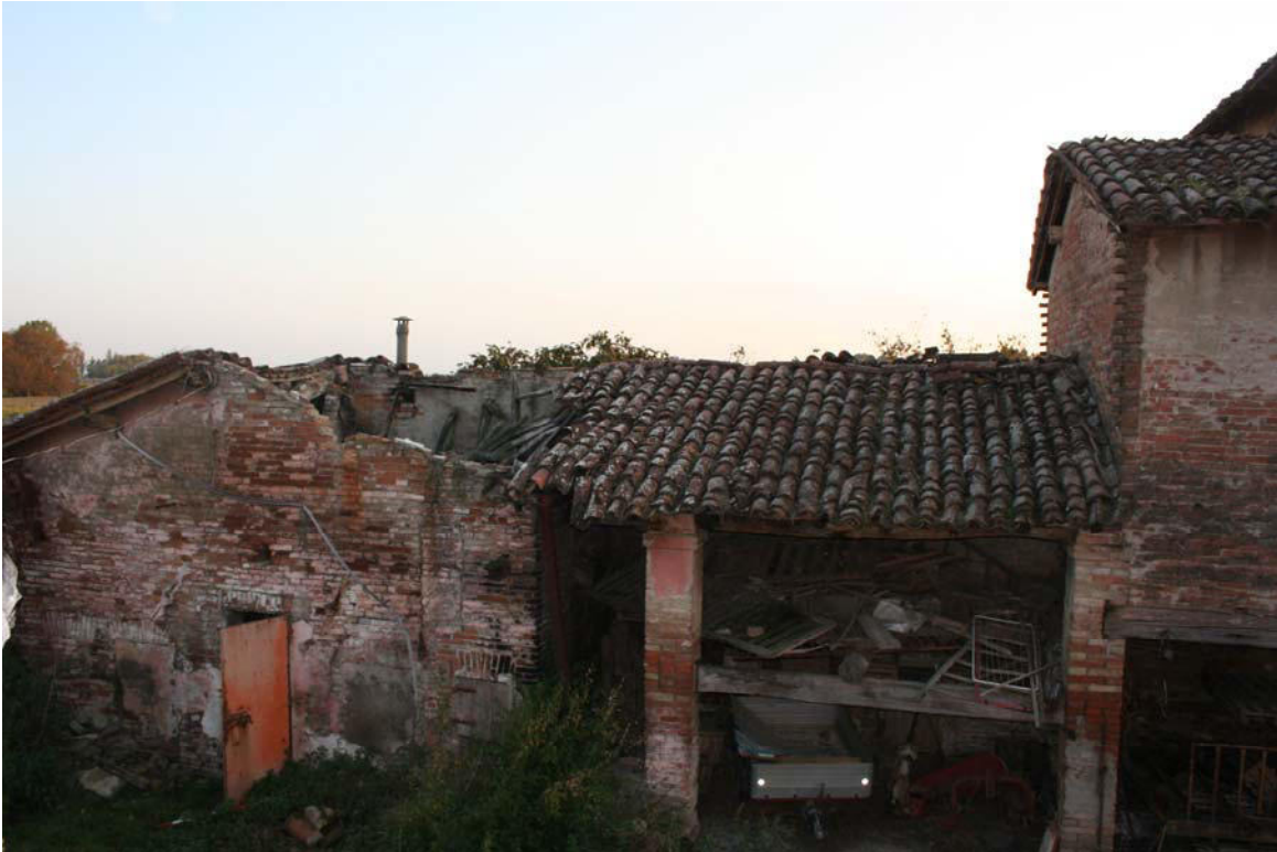
Foto 3 – porzione C - fronte sud ovest
