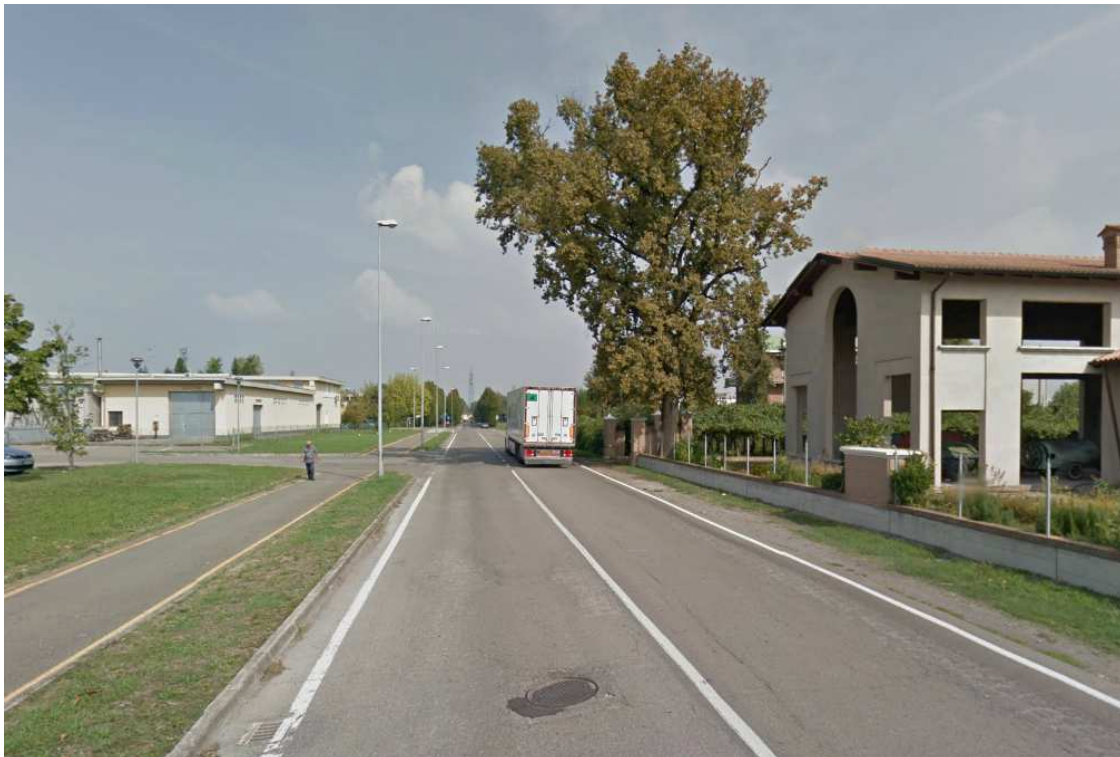
Fig. 19: via Morello di Mezzo
