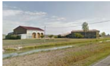
1_Vista da nord-ovest
