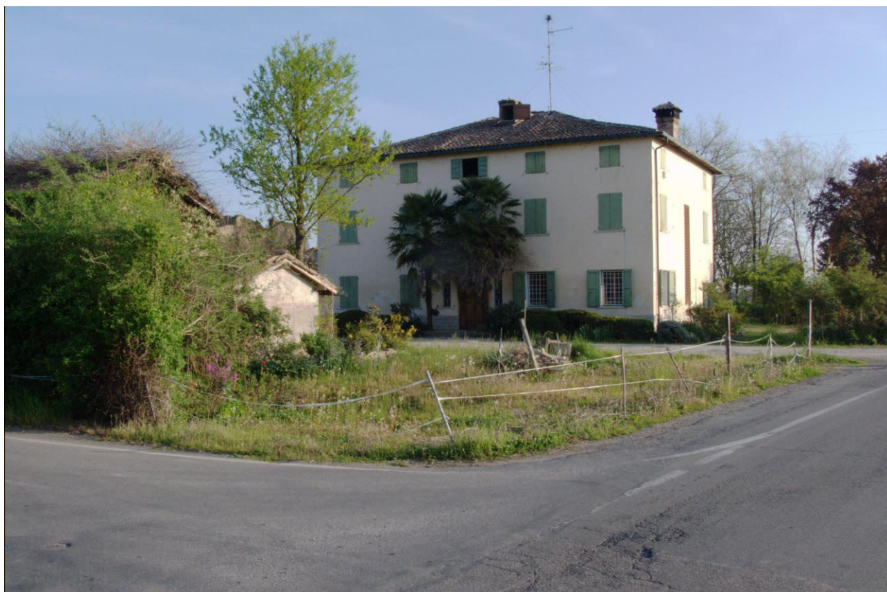
Documentazione fotografica attestante l'avvenuta demolizione (marzo 2014)
