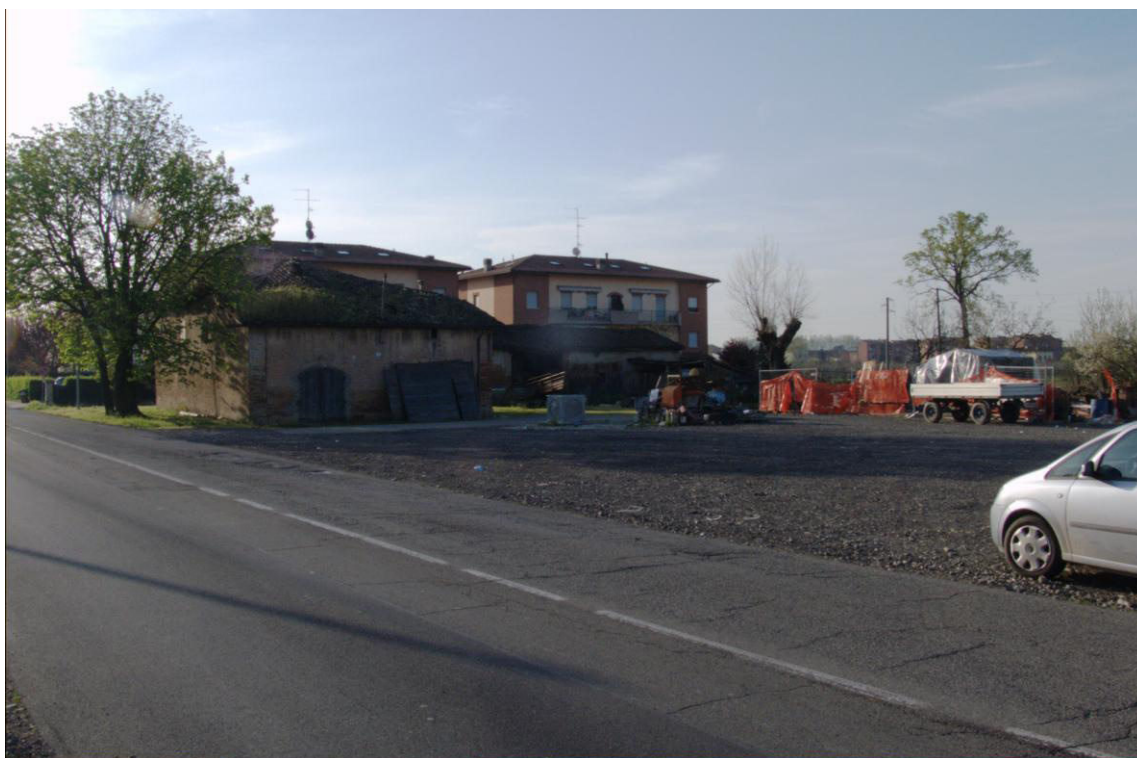
Documentazione fotografica attestante l'avvenuta demolizione (marzo 2014)
