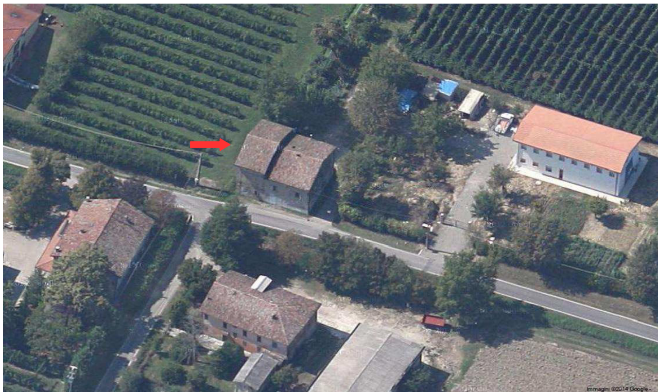
Vista del fabbricato da nord est (Fonte Google maps)
