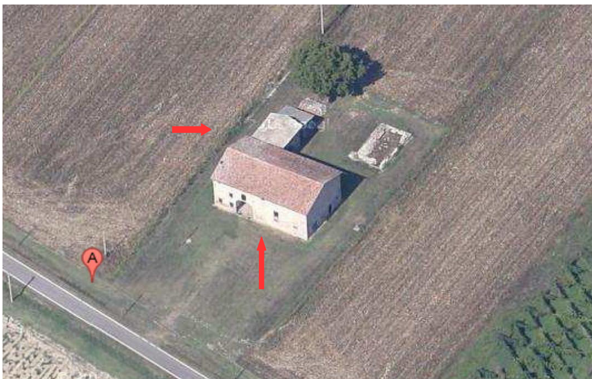
Vista del fabbricato da sud est (Fonte Google maps)
