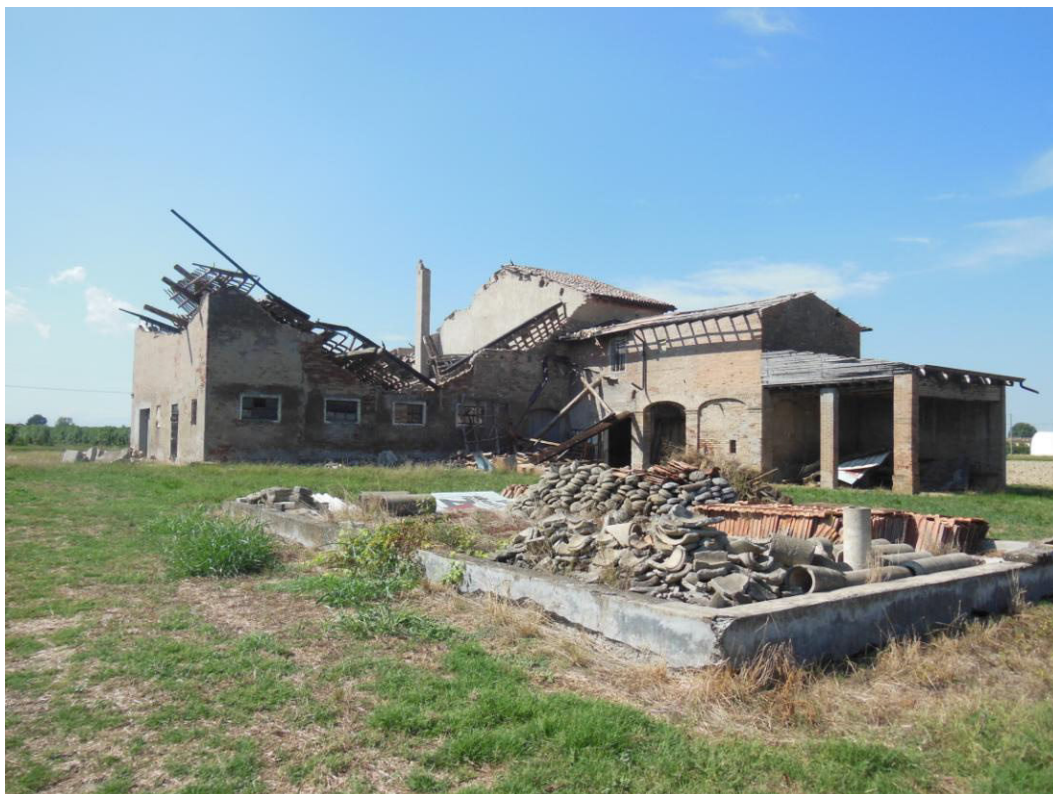
Documentazione fotografica: Vista da nord est (settembre 2013)
