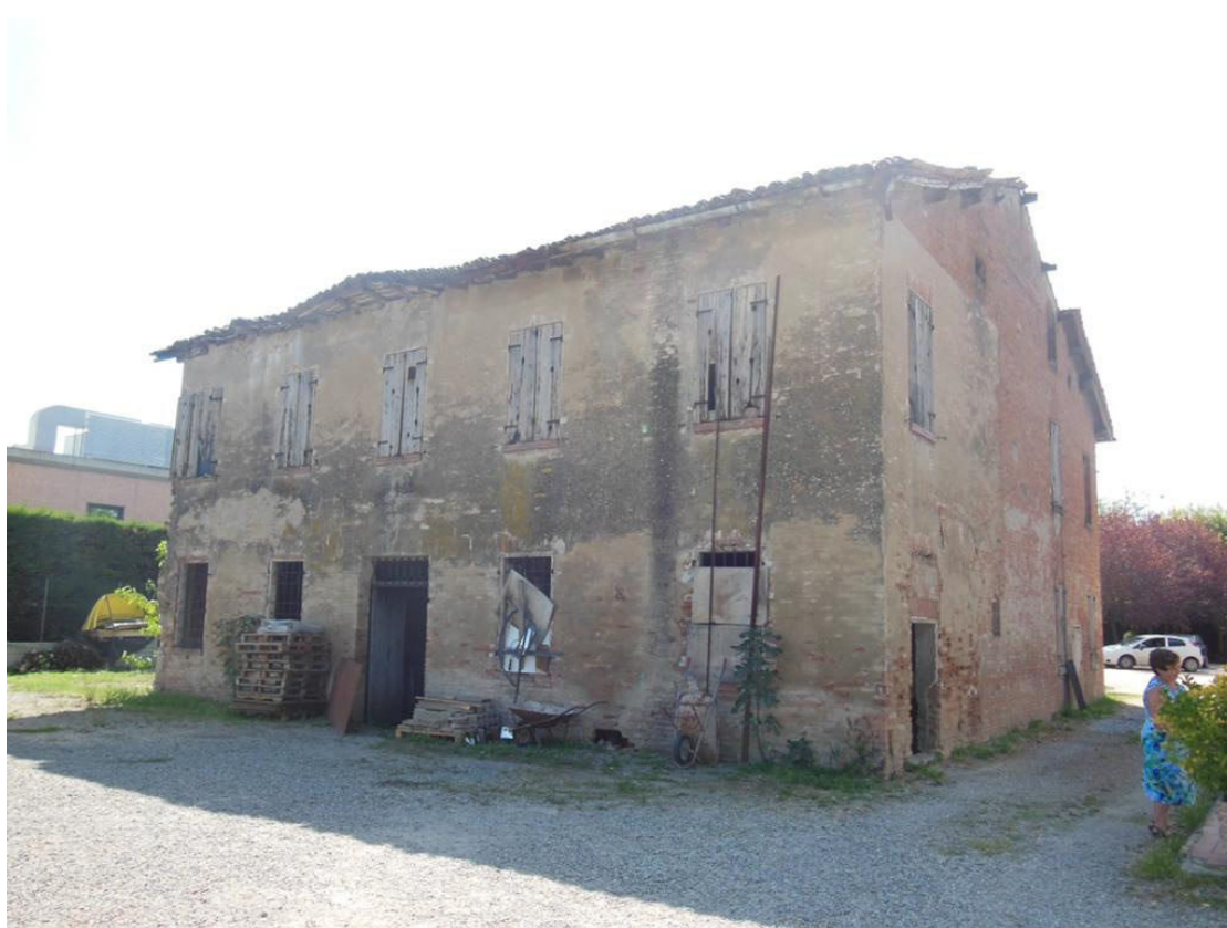
Documentazione fotografica: Prospetto nord est (settembre 2013)
