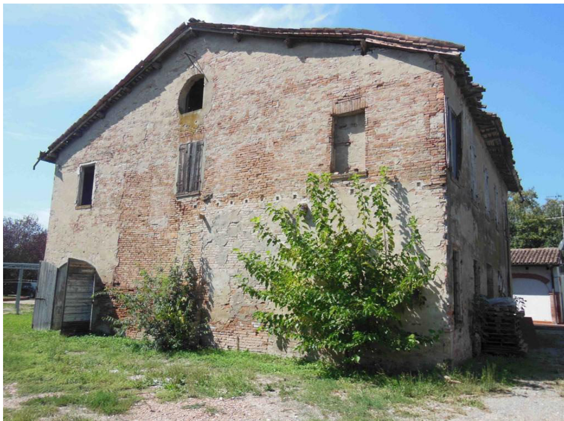
Documentazione fotografica: Prospetto ovest (settembre 2013)
