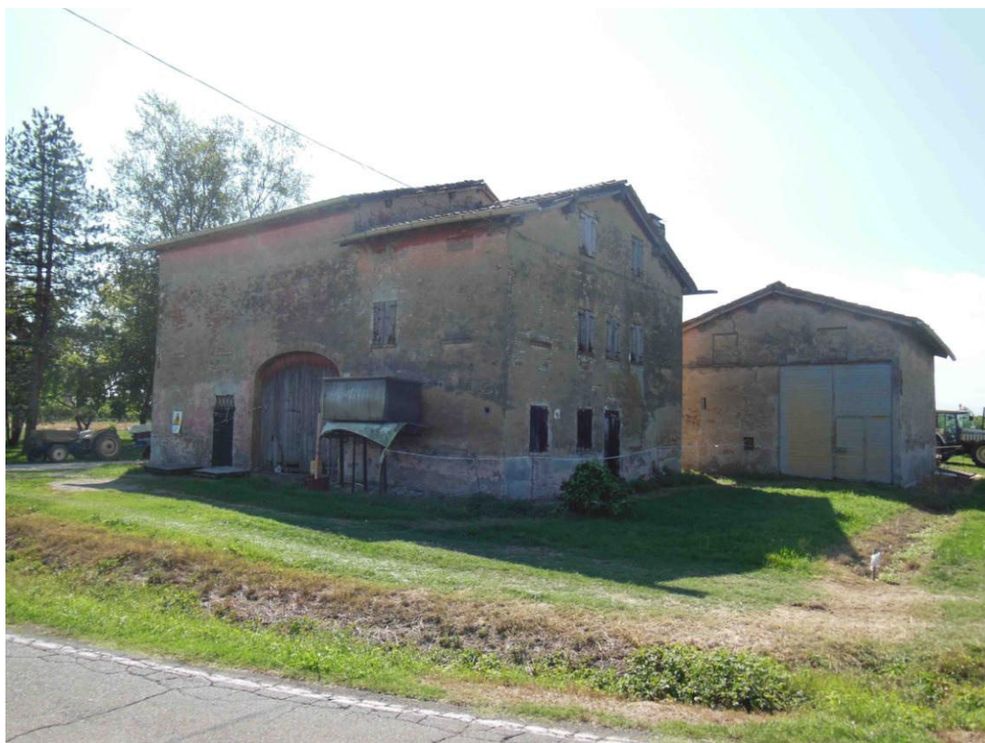
Documentazione fotografica: Vista da Via Serrasina, nord. In primo piano il deposito/abitazione (settembre 2013)
