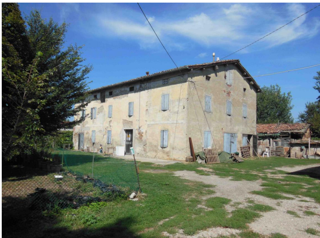
Documentazione fotografica: Vista dal vialetto d'ingresso a sud est (settembre 2013)
