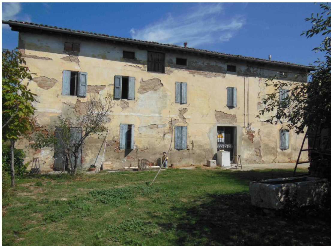
Documentazione fotografica: Vista da Via Morello di Mezzo, da sud ovest (settembre 2013)
