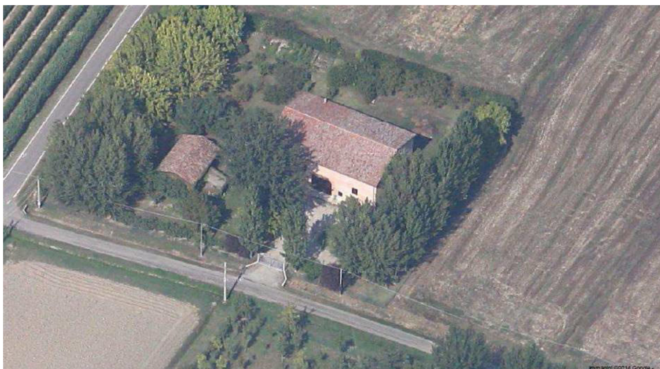
Vista del fabbricato da sud est (Fonte Google maps)
