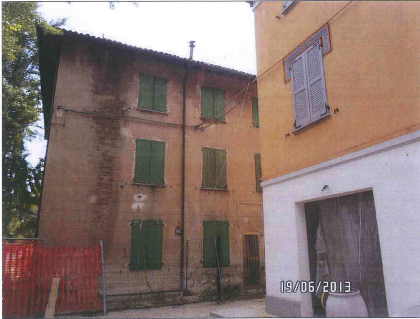
05. VISTA DA NORD
