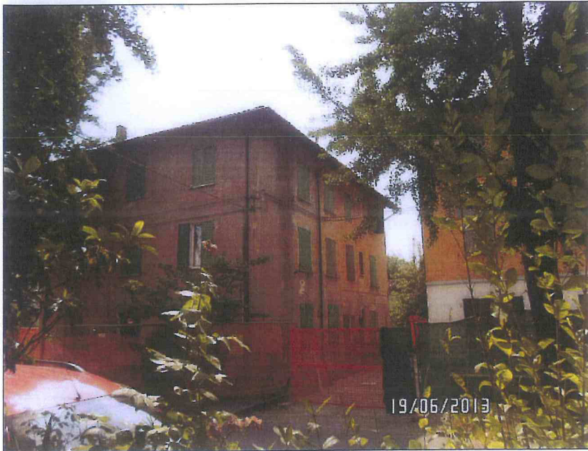
01. VISTA DA VIA MATTEOTTI
