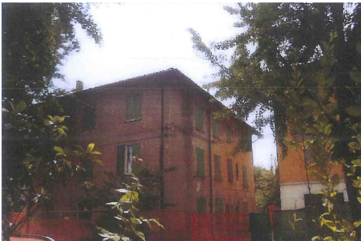
Documentazione fotografica: Prospetti nord ed est (2013)
