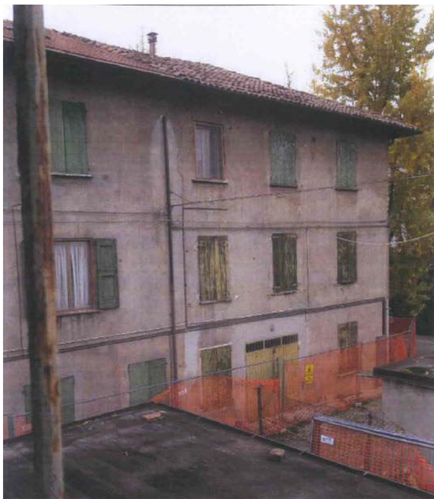
Documentazione fotografica: Prospetto sud (2013)
