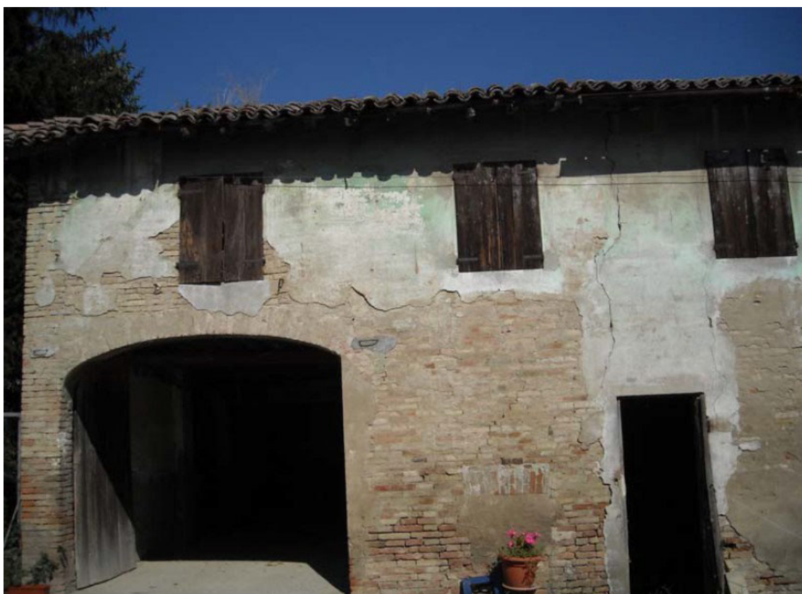
Documentazione fotografica: Prospetto sud (2013)
