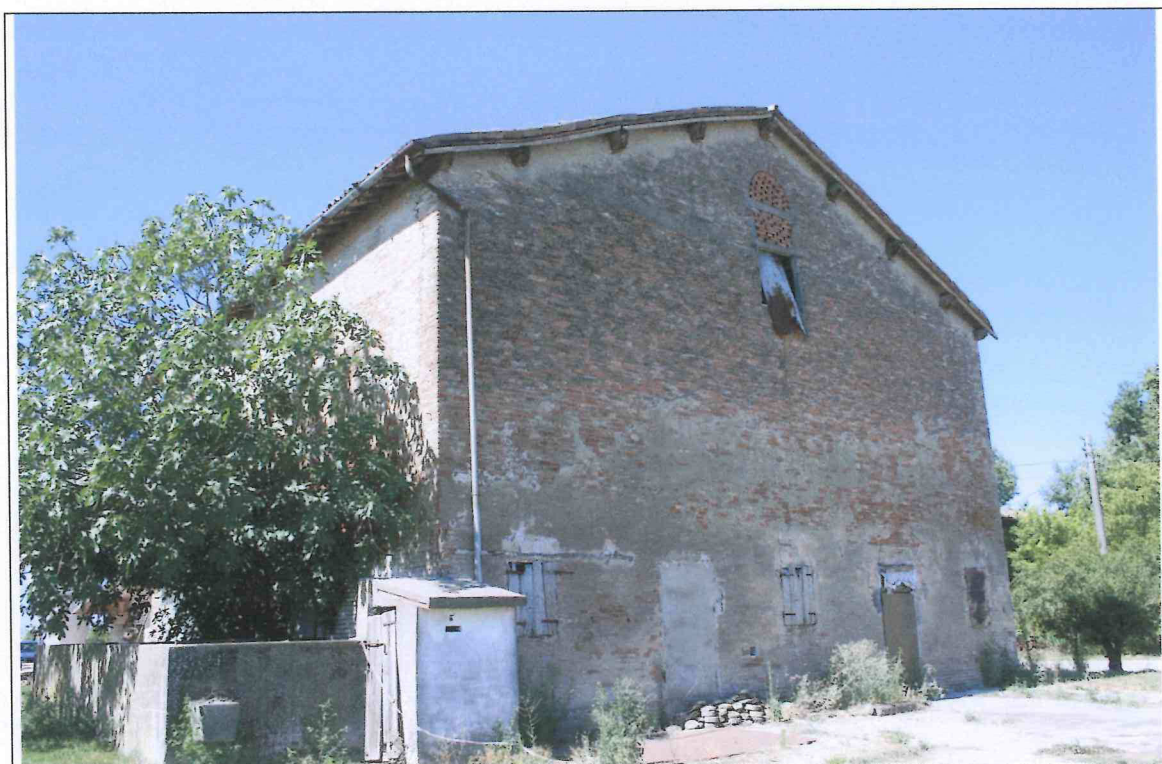
Foto n.1 – fronte nord ovest
