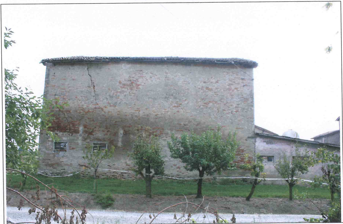
Foto n.3 - fronte nord est
