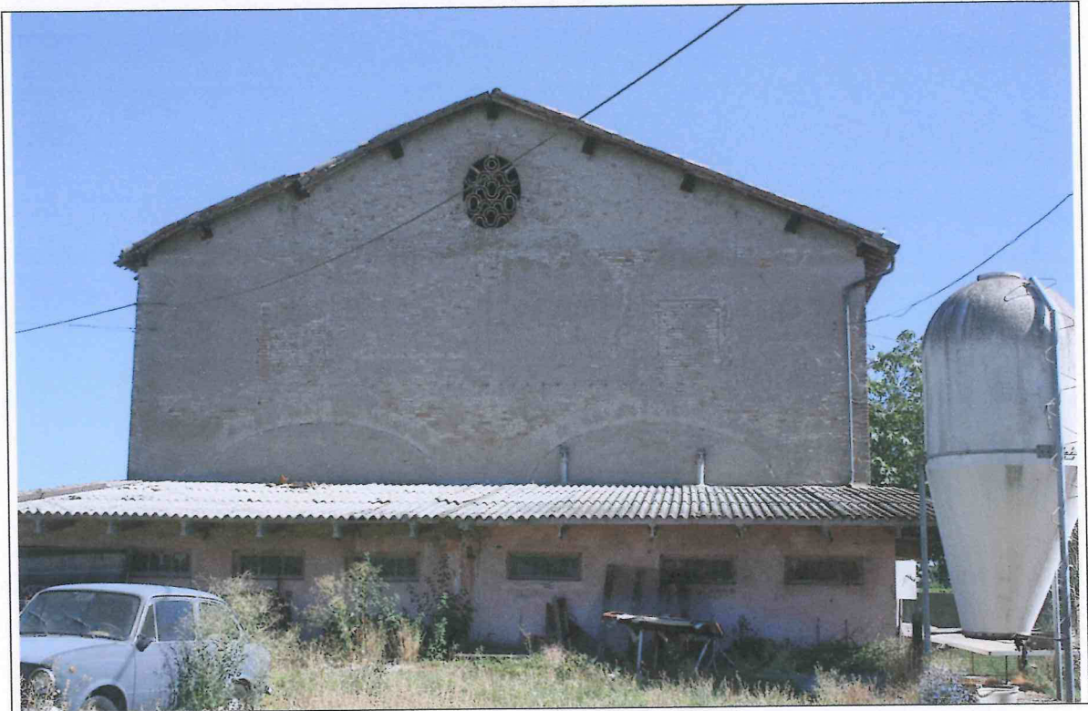
Foto n.2 – fronte sud est
