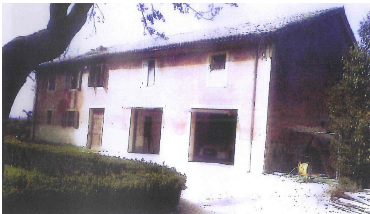
Documentazione fotografica – prospetto ovest (Fonte Google maps)
