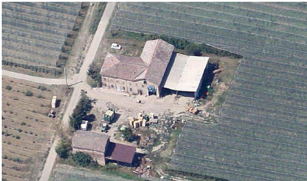
Vista della corte da est (Fonte Google maps)
