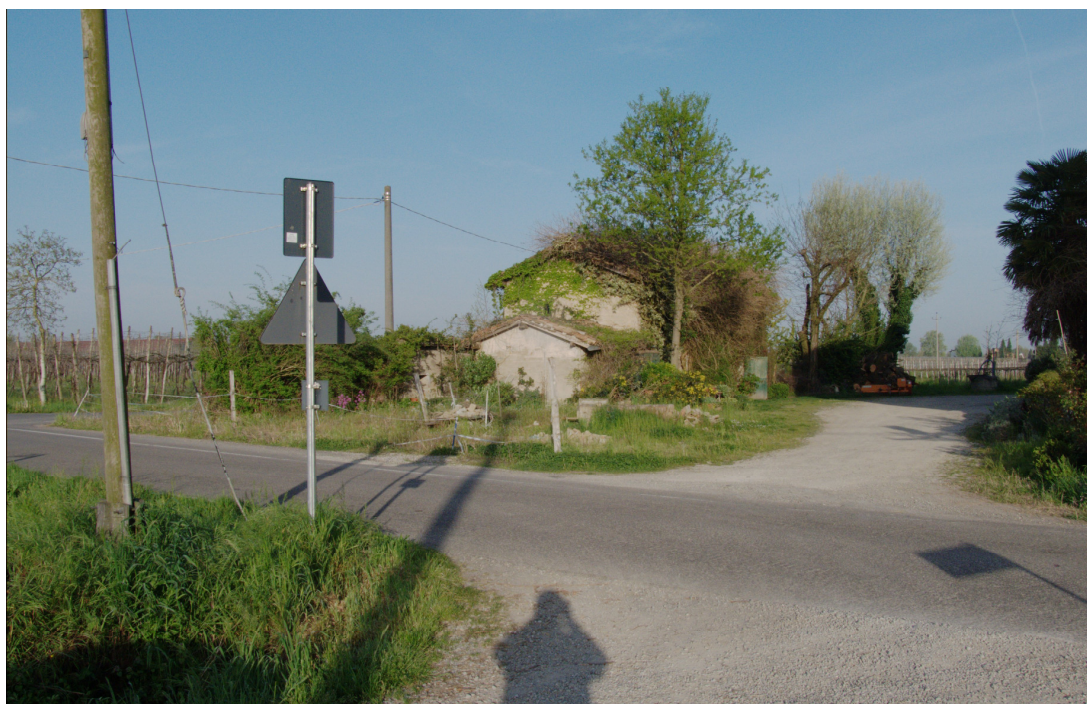
Documentazione fotografica attestante l'avvenuta demolizione (marzo 2014)
