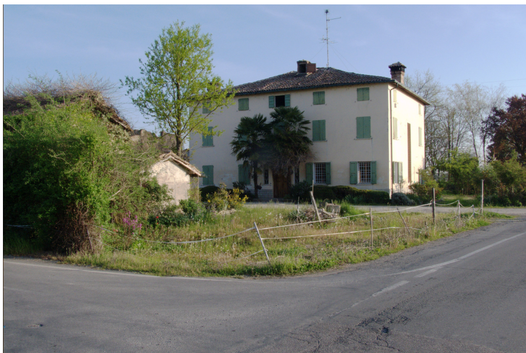
Documentazione fotografica attestante l'avvenuta demolizione (marzo 2014)
