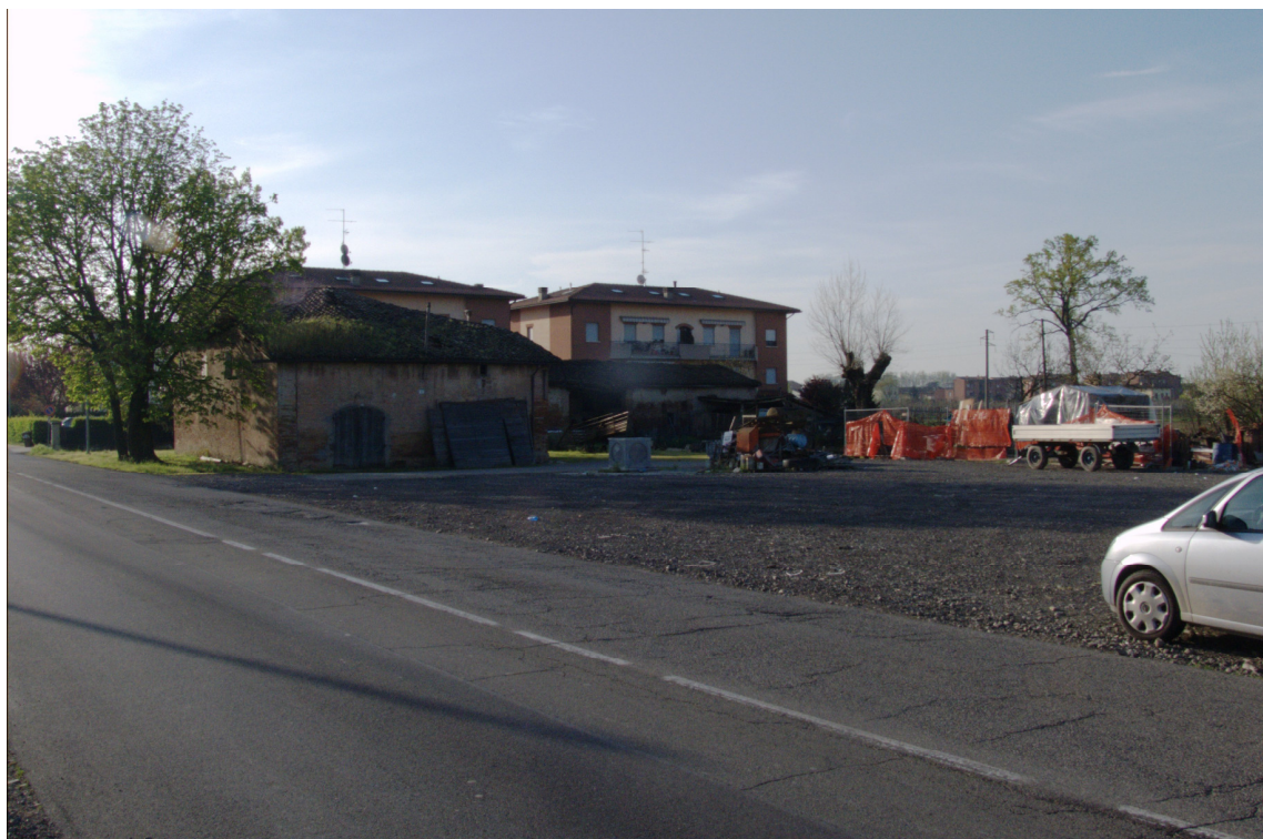
Documentazione fotografica attestante l'avvenuta demolizione (marzo 2014)
