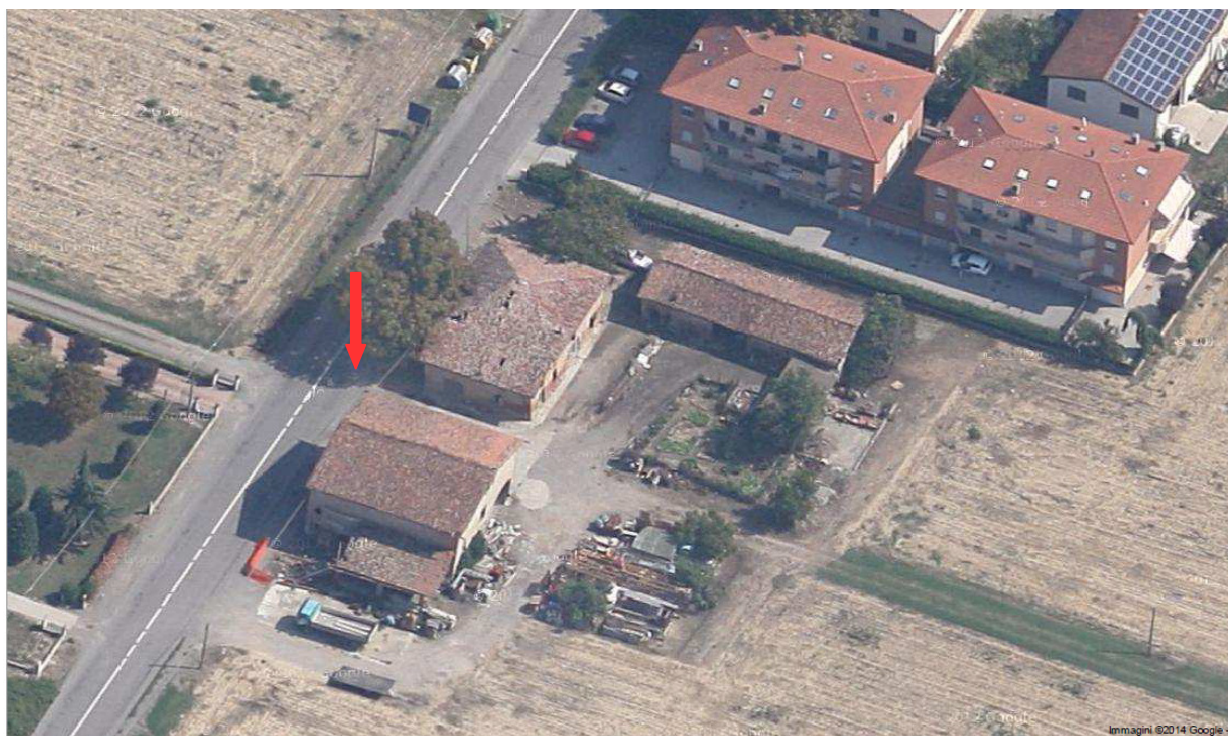
Vista della corte colonica da sud ovest (Fonte Google maps)
