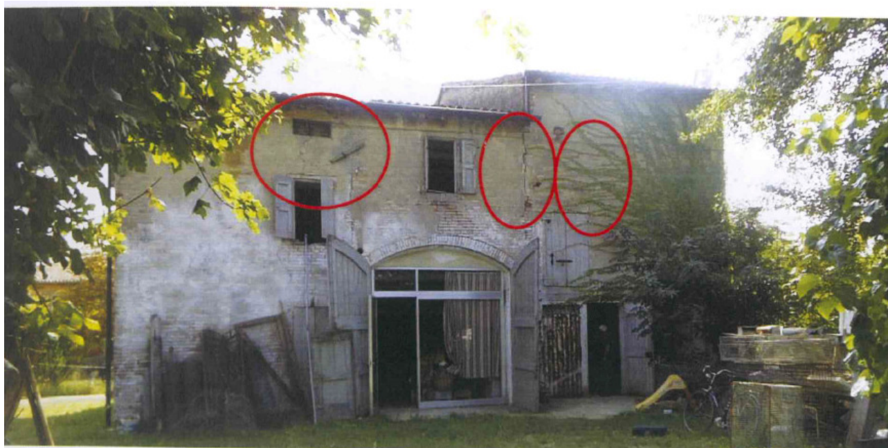
Documentazione fotografica: Prospetto ovest (2013)
