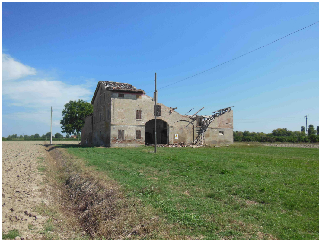
Documentazione fotografica: Vista da Via Serrasina (settembre 2013)
