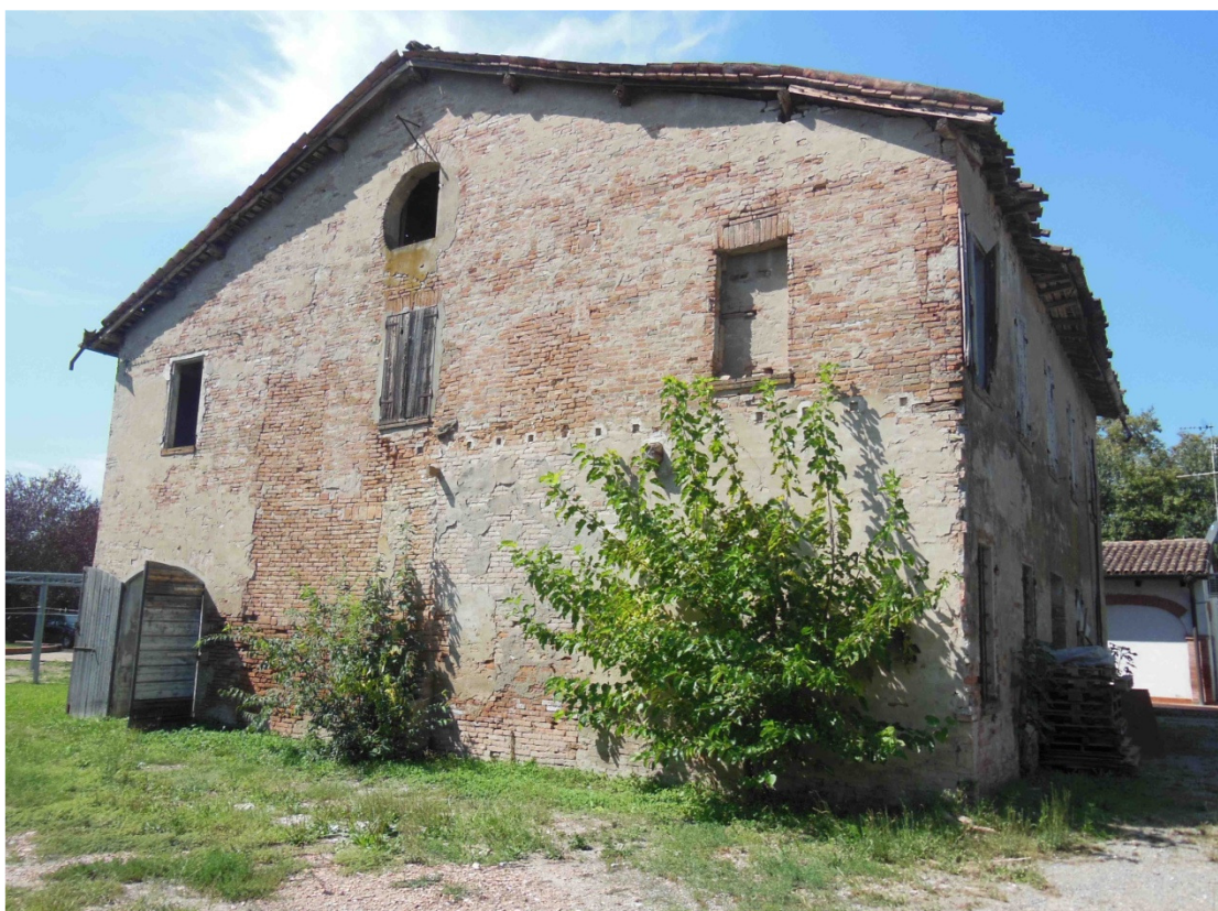
Documentazione fotografica: Prospetto nord est (settembre 2013)
