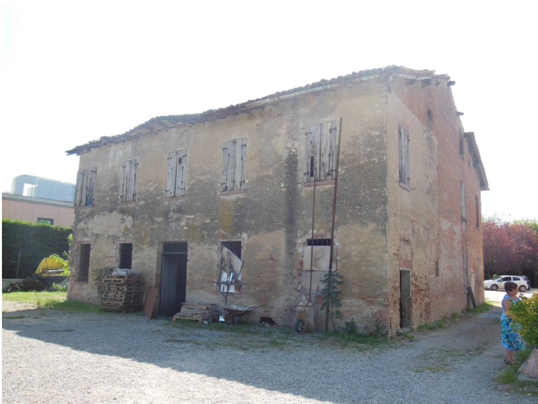
Documentazione fotografica: Prospetto ovest (settembre 2013)
