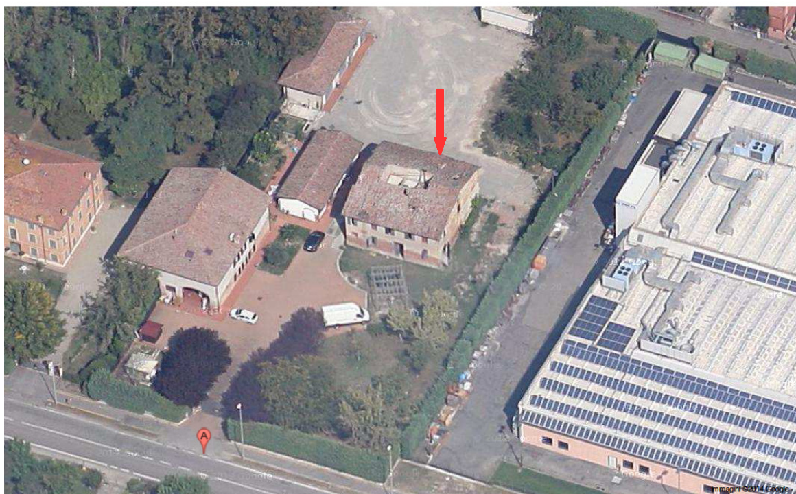
Vista del fabbricato da sud est (Fonte Google maps)
