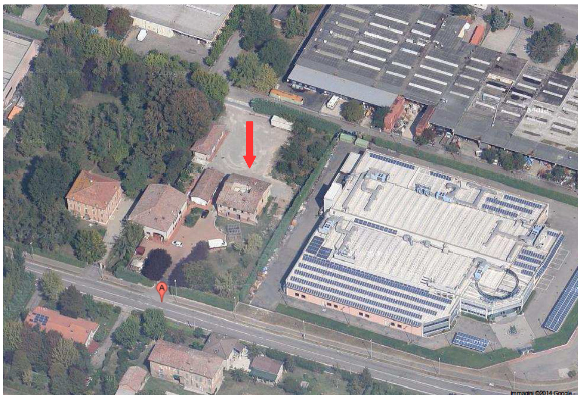
Vista della corte da sud est (Fonte Google maps)
