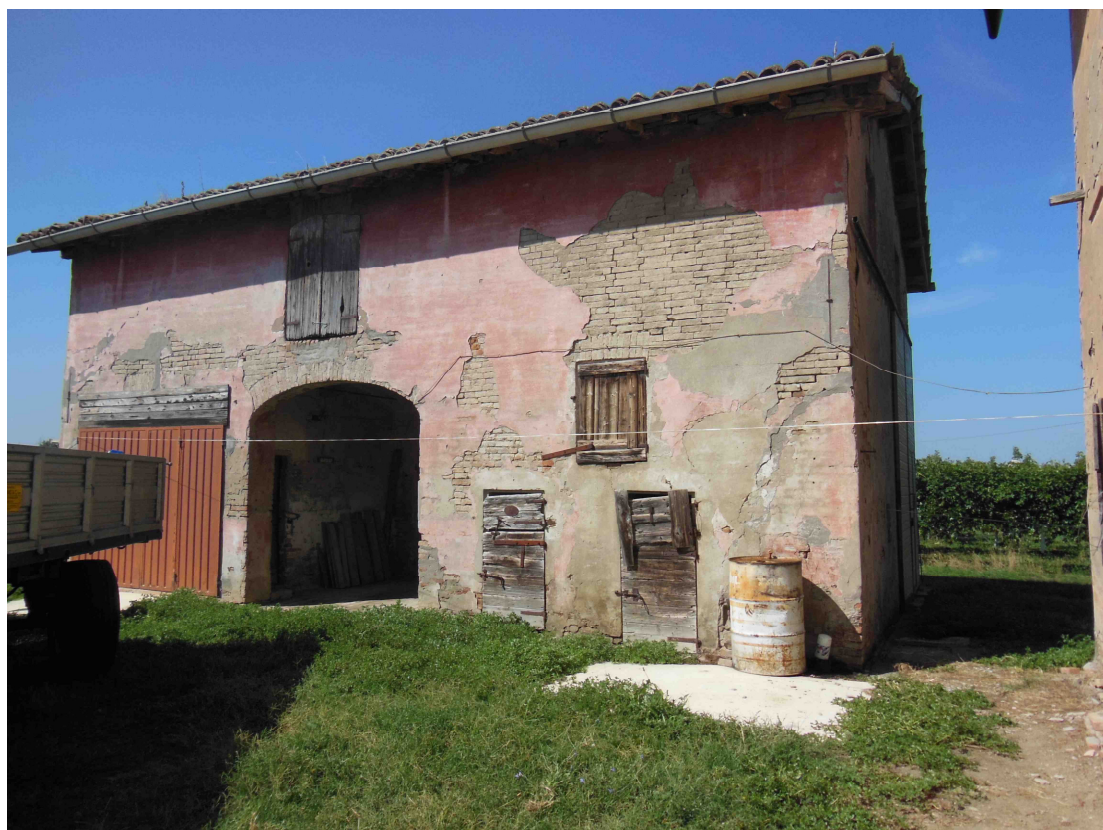
Documentazione fotografica: Vista da est del fienile (settembre 2013)
