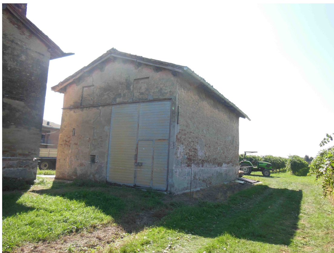
Documentazione fotografica: Vista da nord, da Via Serrasina, del fienile (settembre 2013)
