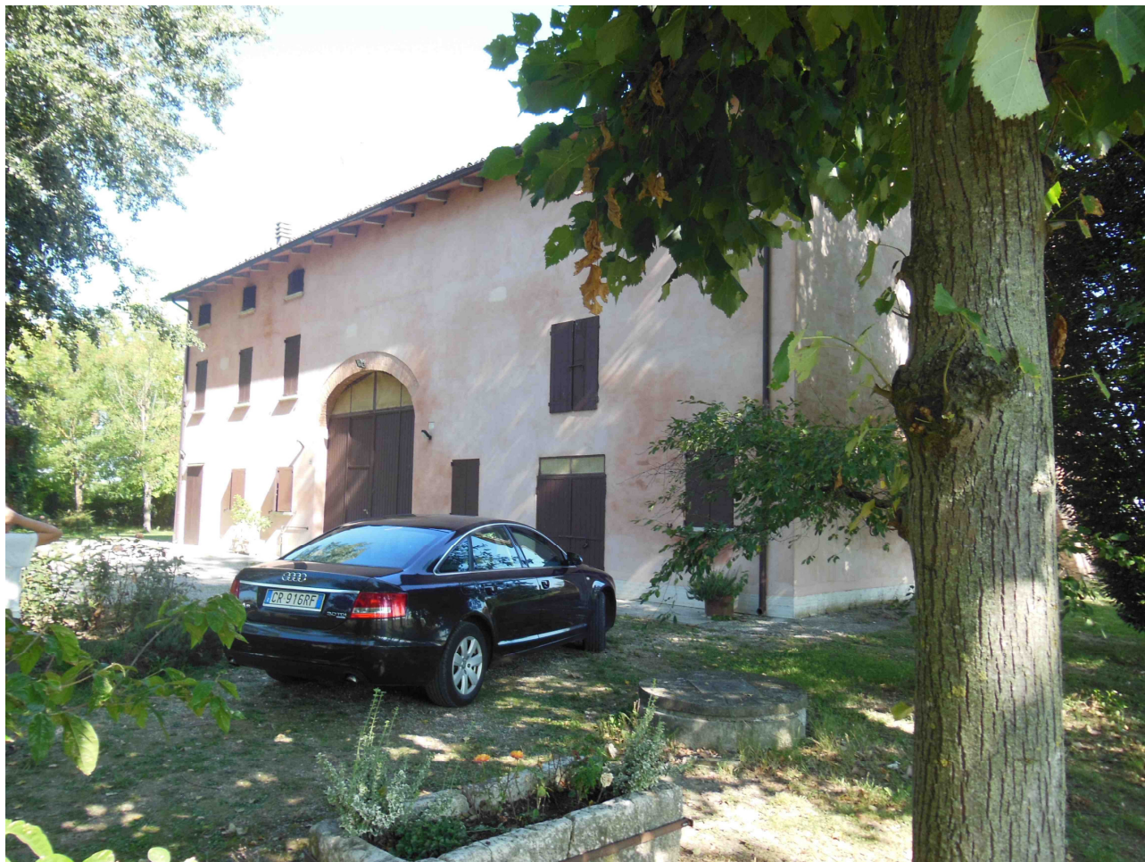
Documentazione fotografica: Vista da sud est (settembre 2013)
