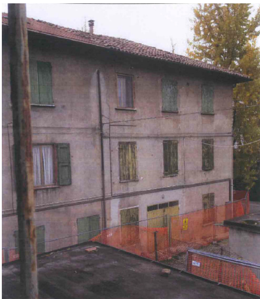
Documentazione fotografica: Prospetto sud (2013)
