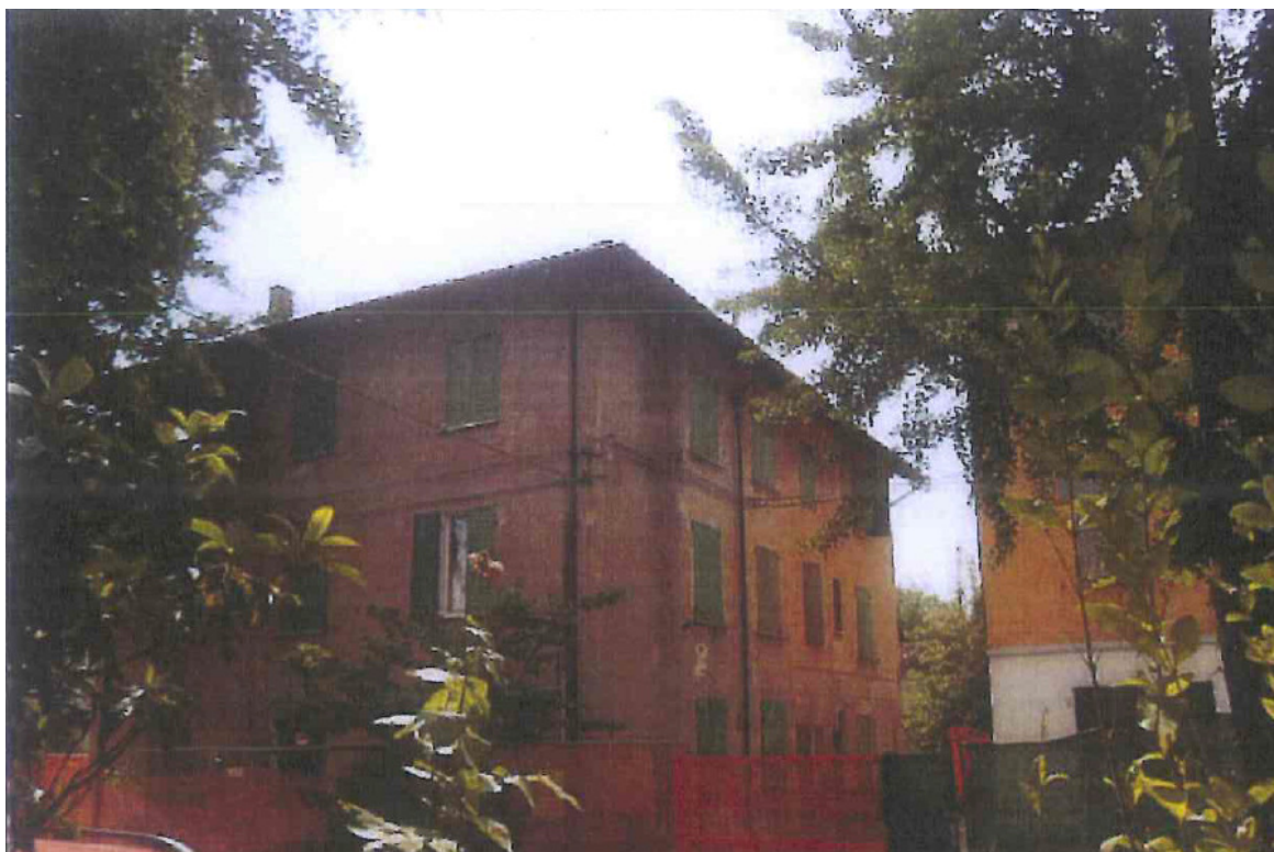
Documentazione fotografica: Prospetti nord ed est (2013)
