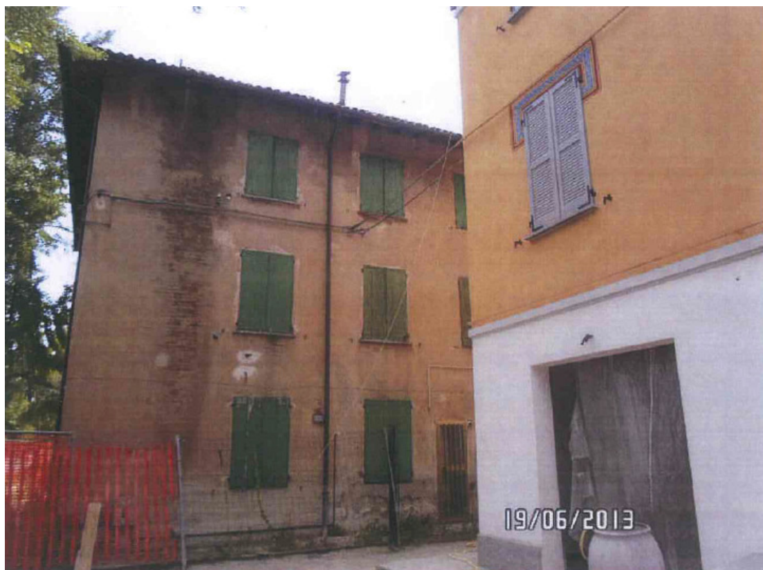
Documentazione fotografica: Prospetto nord (2013)
