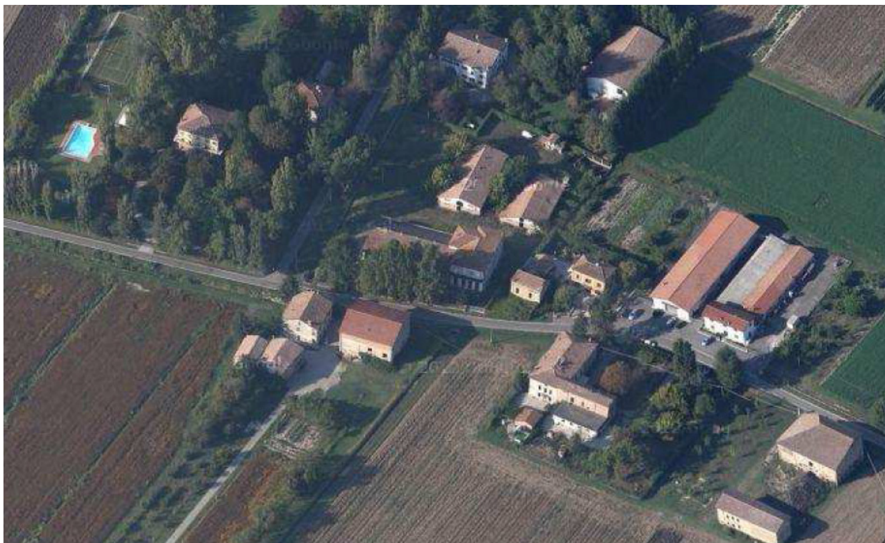
Vista dei fabbricati da sud est (Fonte Google maps)
