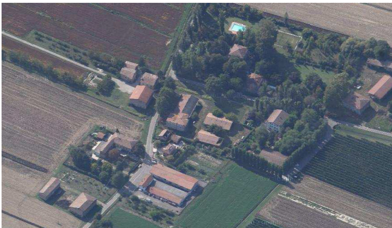
Vista dei fabbricati da nord est (Fonte Google maps)
