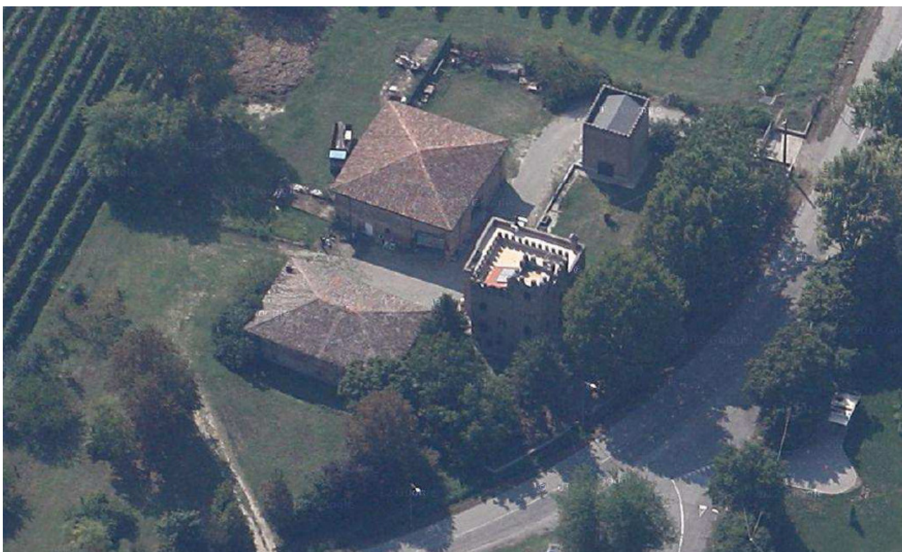
Vista del complesso colonico da nord (Fonte Google maps)
