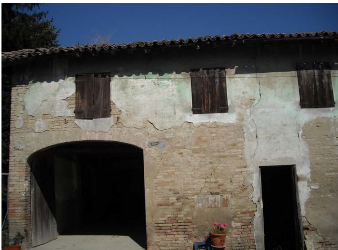
Documentazione fotografica: Prospetto sud (2013)
