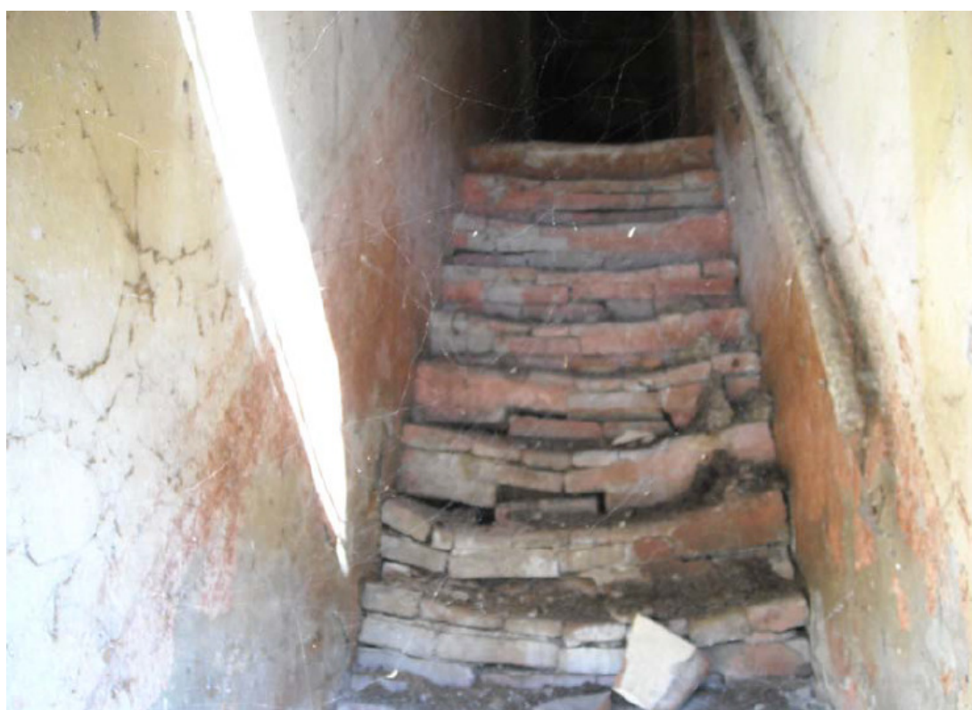
Documentazione fotografica: particolare della scala interna (2013)
