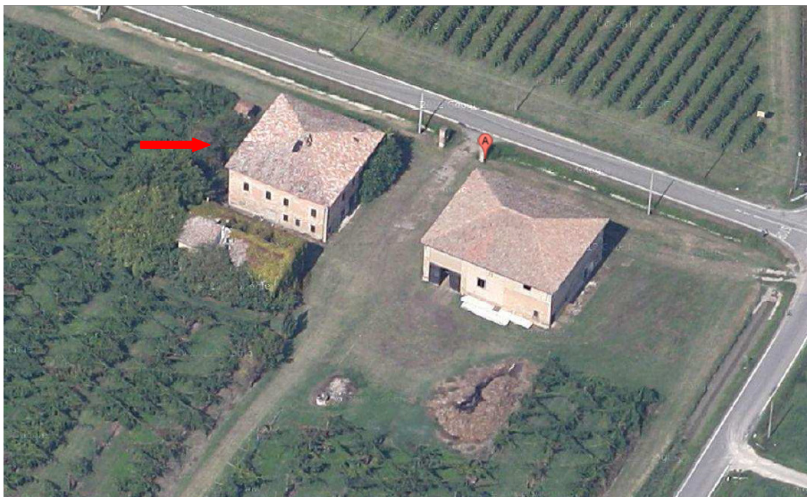
Vista della corte da sud (Fonte Google maps)
