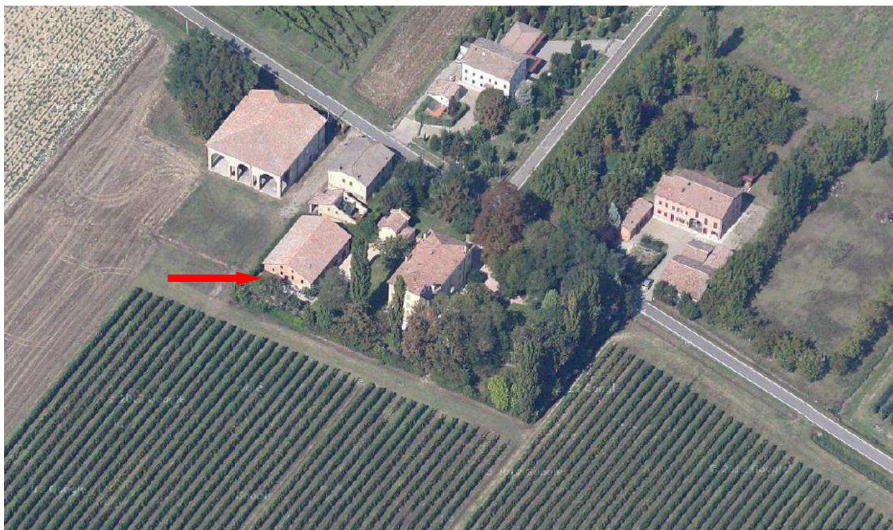
Vista della corte colonica da sud (Fonte Google maps)
