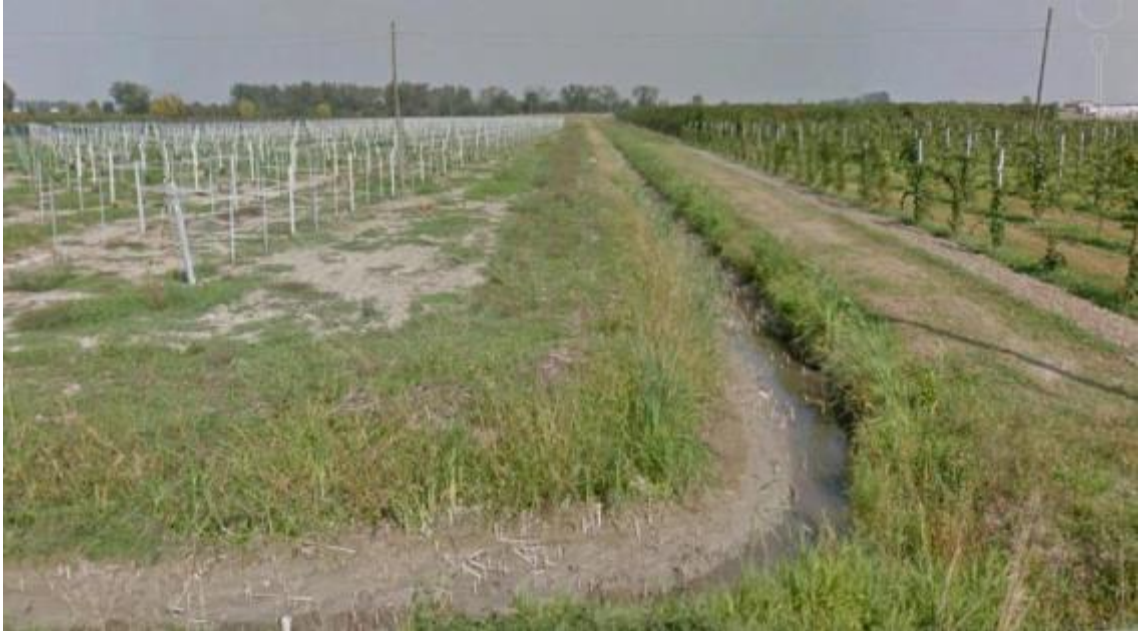
Foto 4.5/A - Scolo Zappellaccio; vista dell'attraversamento dalla Strada Comunale Morello (da Google Earth)
