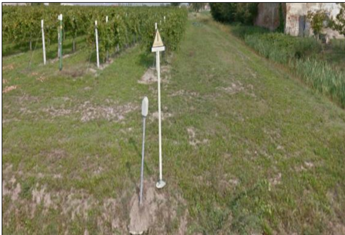
Foto 4.9/A - Ripresa verso nord dalla carreggiata di via Morello di Mezzo. In evidenza la palina di segnalazione della condotta in dismissione da rimuovere - All. Com. di Soliera DN 80 (3'')
