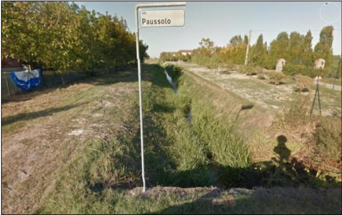
Foto 4.5/E – Cavo Paussolo; vista dell'attraversamento dalla Via Paussolo (da Google Earth)
