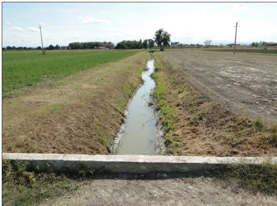
Foto 4.2/K. - Scolo S. Michele; vista verso S in prossimità dell'attraversamento del metanodotto in progetto.
