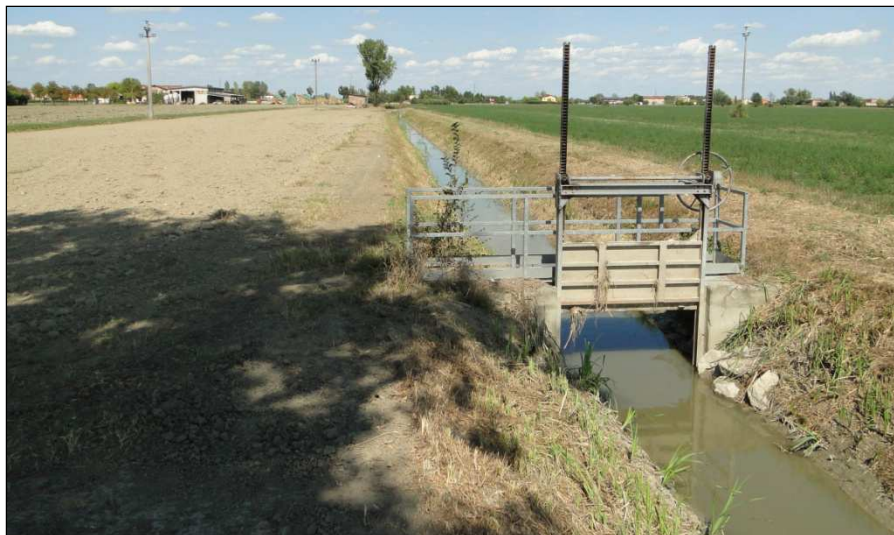
Foto 4.2/I. – Scolo S. Michele, vista verso N, in prossimità dell'attraversamento del metanodotto in progetto.
