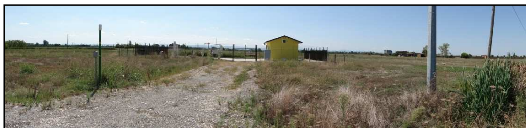
Foto 4.2/A. - Vista da Strada Morello verso S; nel centro, visibile l'impianto Snam Rete Gas.
